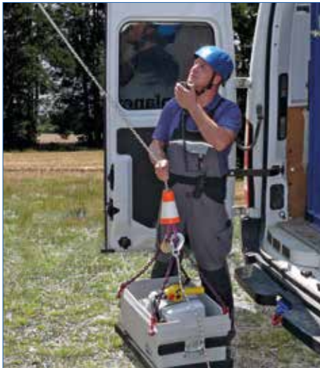
Austausch von Hebezeugen in Windkraftanlagen
