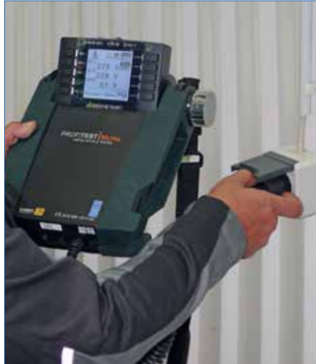
Überprüfung elektrischer Anlagen
