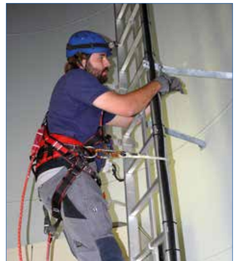
Überprüfung von Steigschutzeinrichtungen
